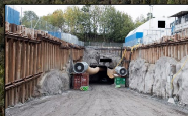
Schaktarbete förskärning – projektering klar, entreprenad under 2026
