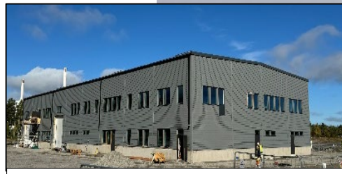
Geologibyggnad – slutbesiktning juni
