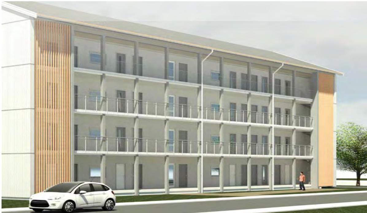
Typhus A med fasadutförande och loftgång
