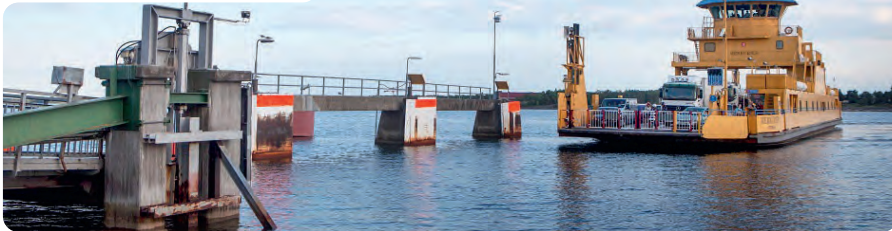
Två hamnar inom Östhammars kommun innefattas av riksintresse sjöfart: Hargshamns och Forsmarks hamn.
